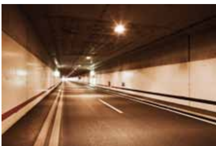
Klassische, rötlich schimmernde Natriumdampf Lampen mit Drosselspule und analogem zentralen Leistungsregler.
